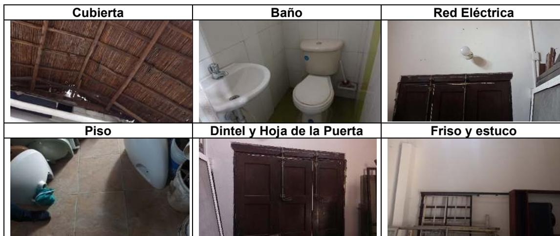
Las obras realizadas en el Local 2 comprenden el cambio de piso (cerámica), Arreglo del dintel de la puerta e instalación y suministro de un abra de la puerta, el cambio de las redes Eléctrica, hidráulica y sanitaria, el friso de los muros, reconstrucción e impermeabilización de la cubierta y construcción e instalación y suministro de baño.
